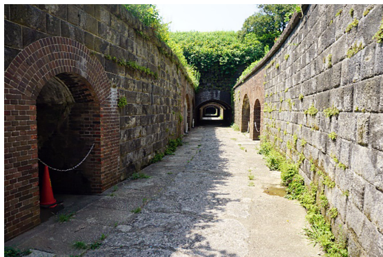
砲台間の通路
