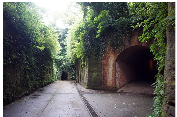
砲台間の通路
