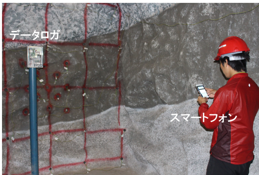
図6.3 実験鉱山での実験の様子 (直線経路)
