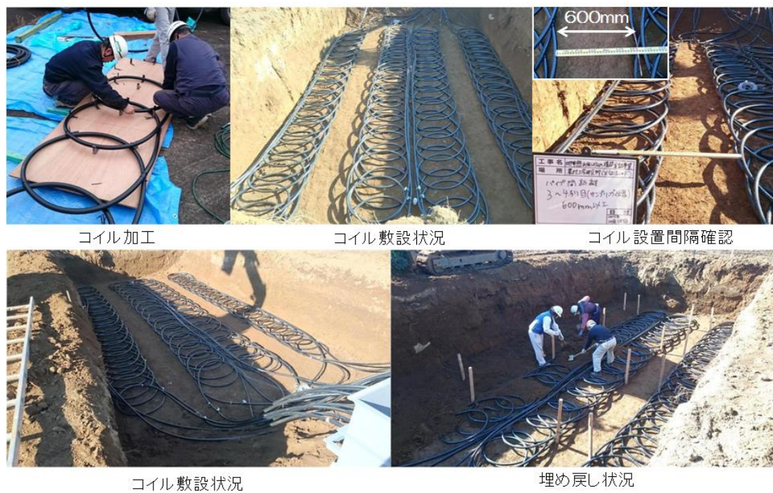
Fig. 19 HGHE 加工・敷設状況
