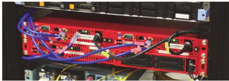
図4 Account@adapter+ ネットワーク接続時の認証や接続の記録がこの機器で行われる
