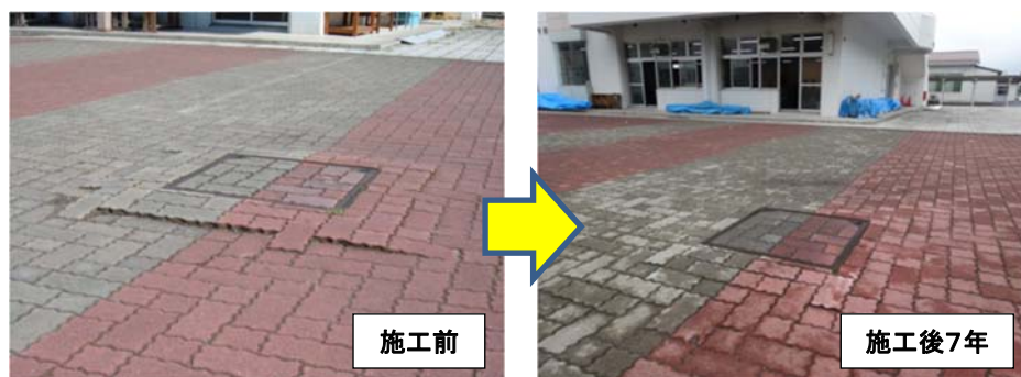
図 5-2-3-1 低強度モルタルのインターロッキングブロック舗装の下地への適用状況
