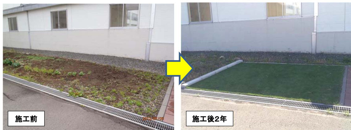
図 5-2-3-6 低強度モルタルの人工芝舗装の路盤および均しモルタルへの適用状況
