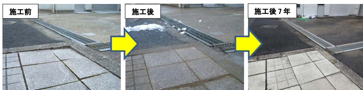
図 5-2-3-3 低強度モルタルの平板ブロック舗装の下地への適用状況 1
