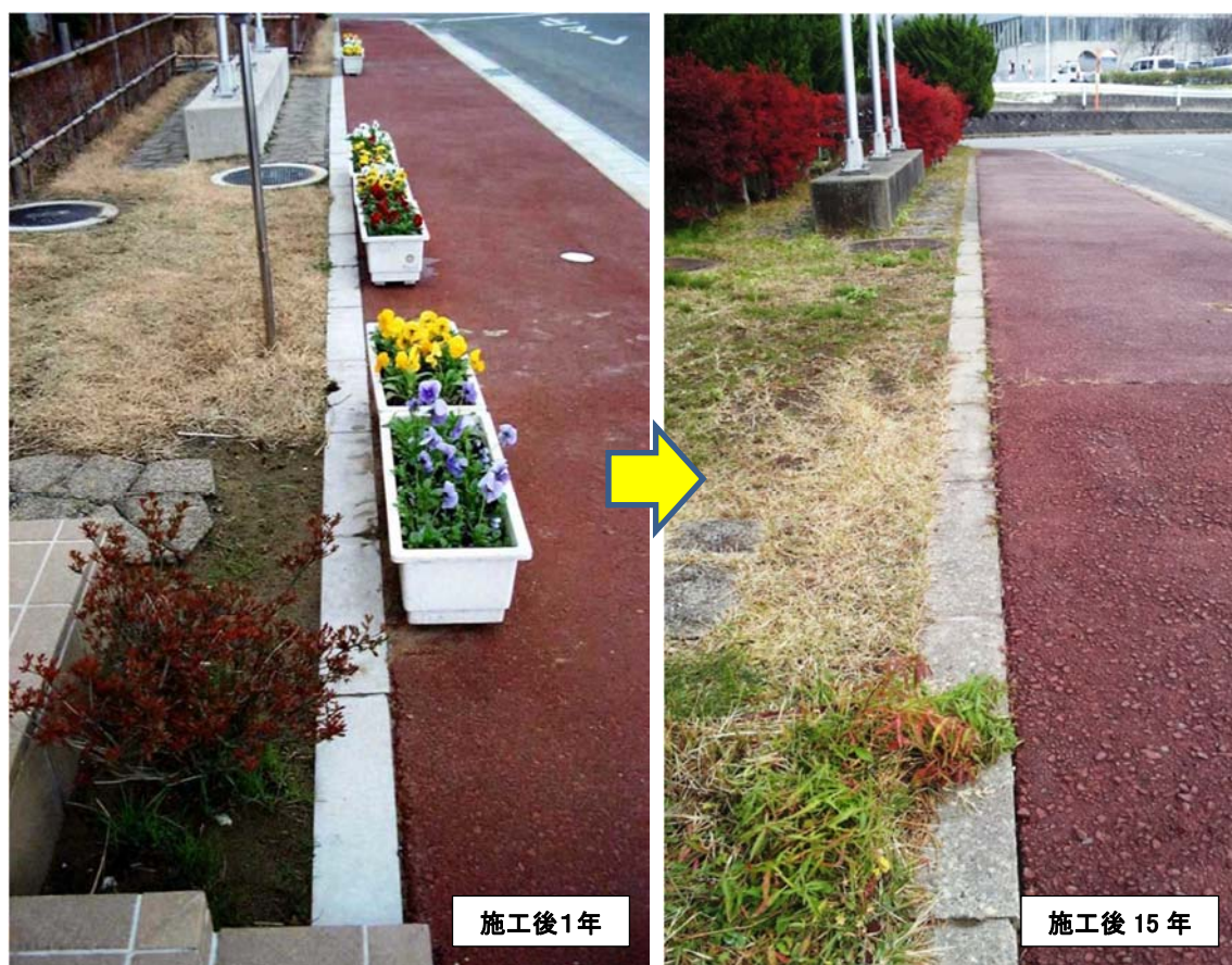
図 5-2-2-1 廃ガラスカレットを細骨材に用いたコンクリートの地先境界ブロックへの適用状況
