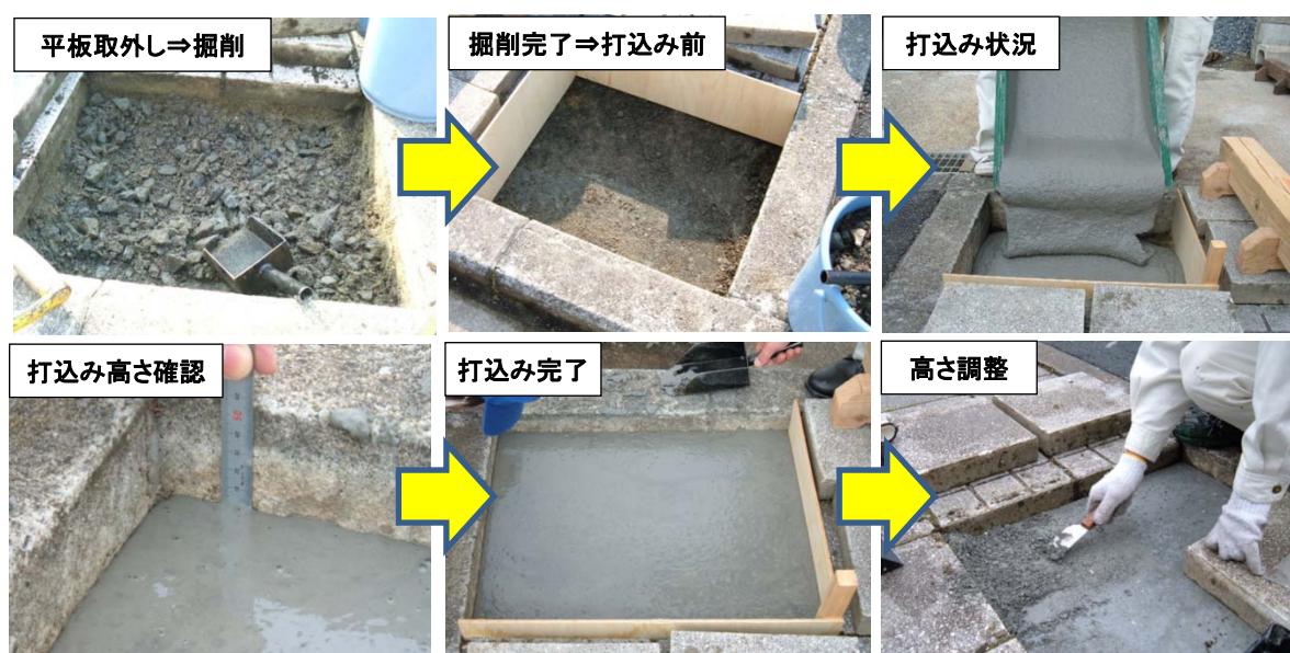
図 5-2-3-4 低強度モルタルの施工状況
