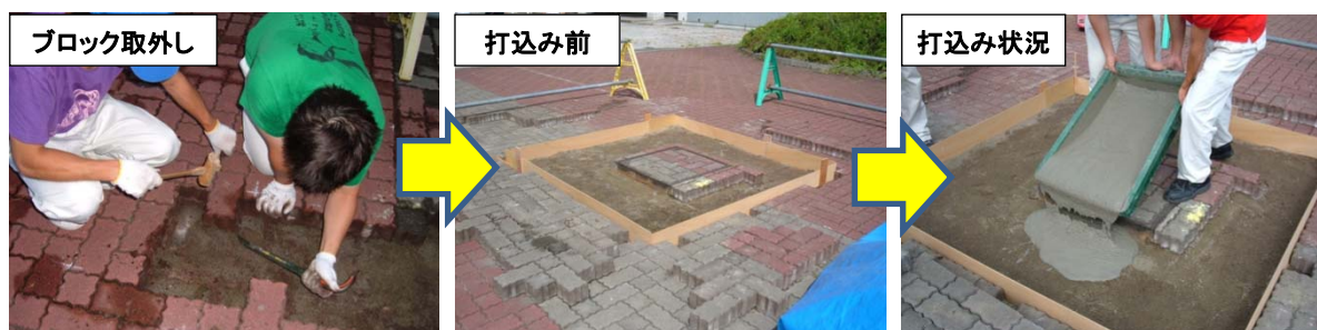
図 5-2-3-2 低強度モルタルの施工状況
